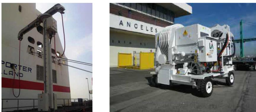
Figura 21. Equipos de Gestión de cable en muelle tipo Fijo (izquierda) y Móvil (derecha). Fuente: PEMA
