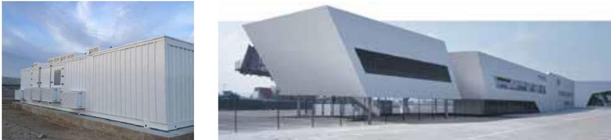
Figura 18.: Subestación para portacontenedores de hasta 2 MVA con conversión de frecuencia (izquierda); Subestación para cruceros de hasta 12 MVA en 6,6 y 11 kV en el muelle Altona del Puerto de Hamburgo (derecha). Fuente: PEMA
