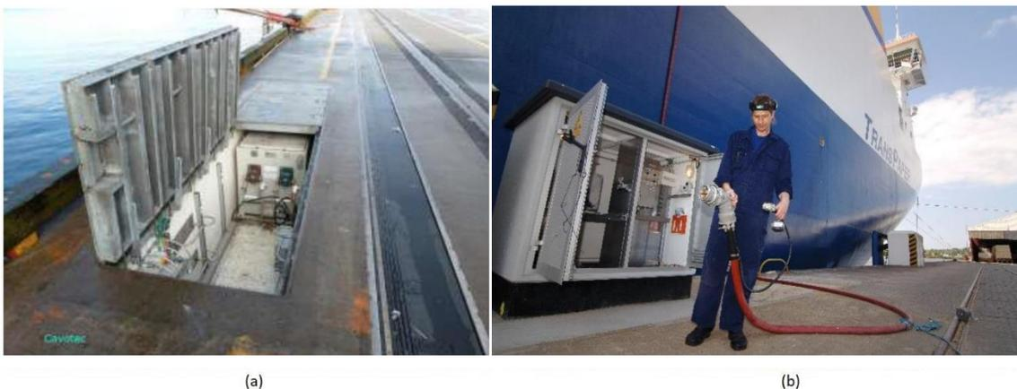
Figura 20. Cajas de conexión. (a) Enterrada (CAVOTEC) -(b) Vertical. Fuente: poweratberth.eu
