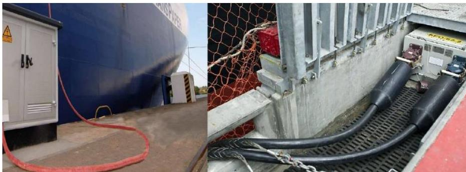
Figura 4. Ejemplo de las cajas de conexiones en el muelle para los cables de a bordo. Fuente: Autoridad Portuaria de Vigo.
