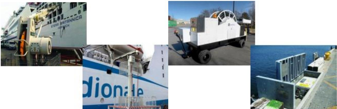
Figura 3. Izda: Sistema de conexión con grúa fija, y dcha.: carros de conexión con arquetas distribuidas en muelle. Fuente: Autoridad Portuaria de Castellón.
