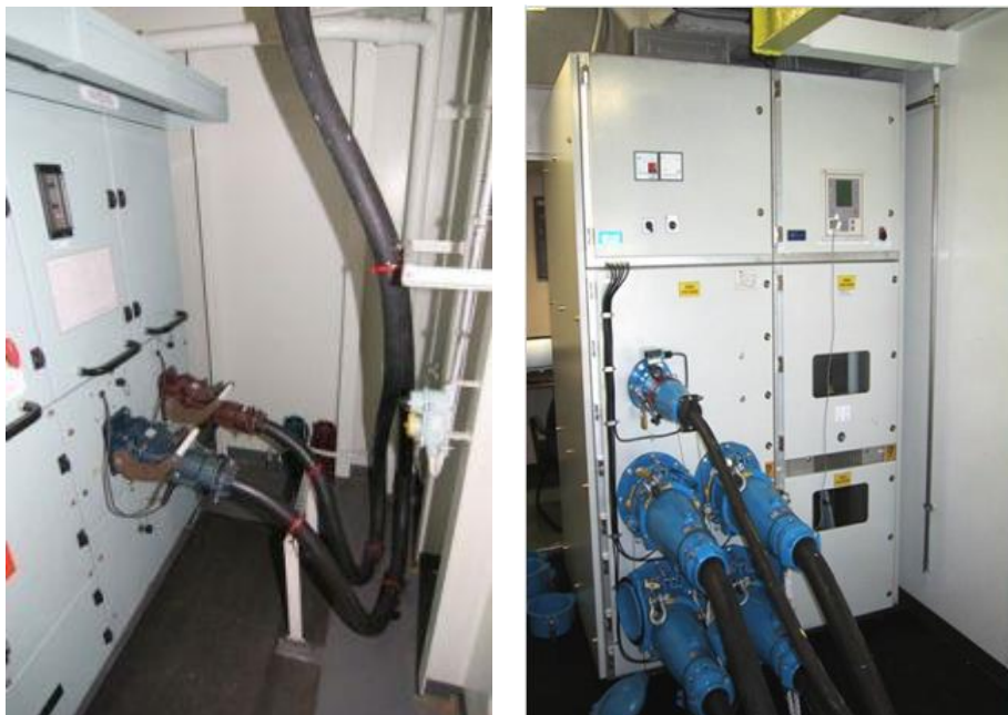
Figura 2.35 Conexión de cables de sistema OPS en alta tensión en buque.
