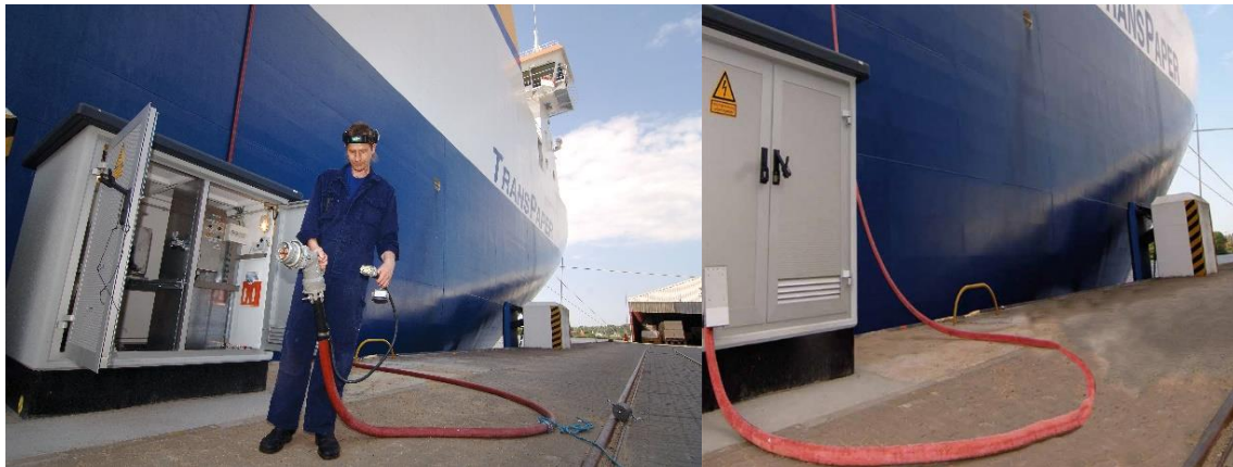
Figura 2.18 – Procedimiento de conexión (izquierda) y buque conectado a un OPS en una caja de conexiones vertical (derecha)
