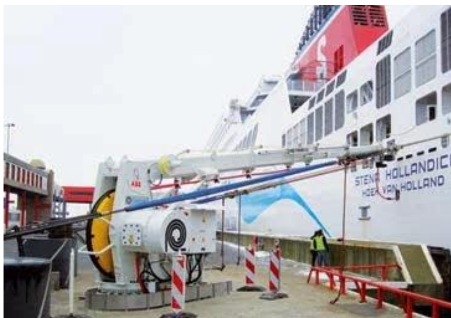
Figura 2.28 Ejemplo de grúa fija de pluma extensible para sistema OPS en el puerto de Rotterdam (Fuente: Cavotec).
