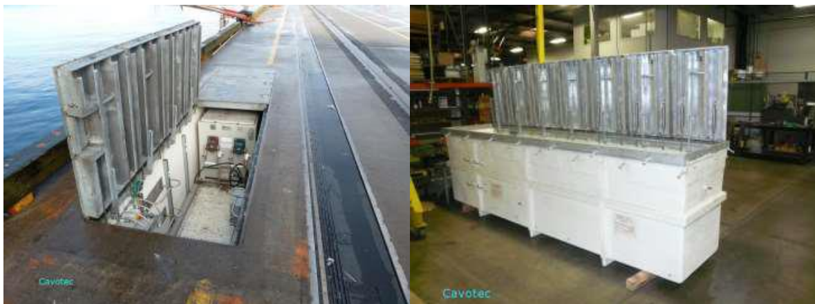
Figura 2.20 Arqueta de conexiones para instalación en el cantil del muelle (Fuente: Cavotec).
