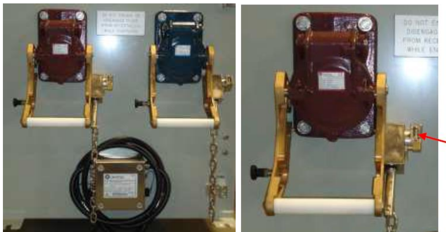
Figura 2.24 Panel de conexión de las tomas de alta tensión (Fuente: Cavotec. Shore junction box)
