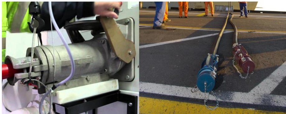
Figura 2.39 - Conectores de Cavotec para cables eléctricos (izquierda) y cables con aislantes de los conectores de un cable de conexión desplegados desde un buque portacontenedores
